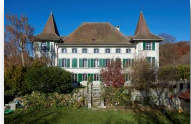
Château de Grange-Verney, chantier suivi par le SIPaL en 2014-2015
