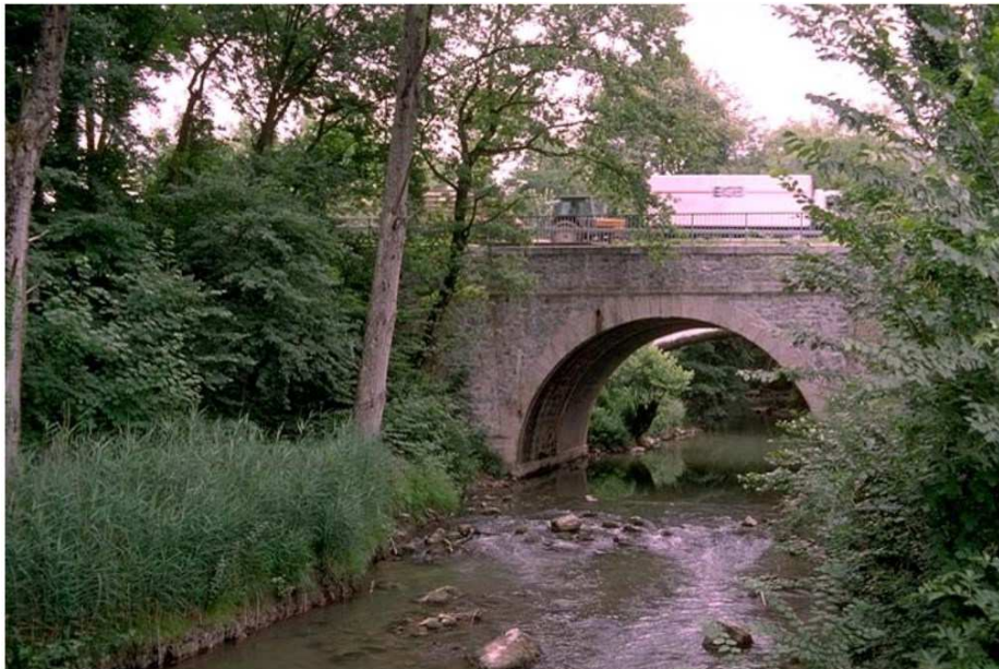
Figure 10 : Pont sur la Venoge (vue côté sud)
