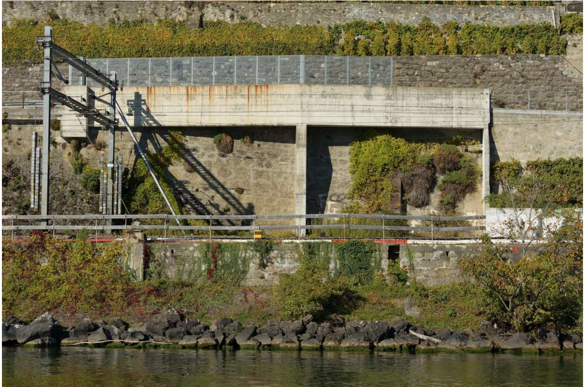
Fig. 24 : estacade des Moulins-Dessous
