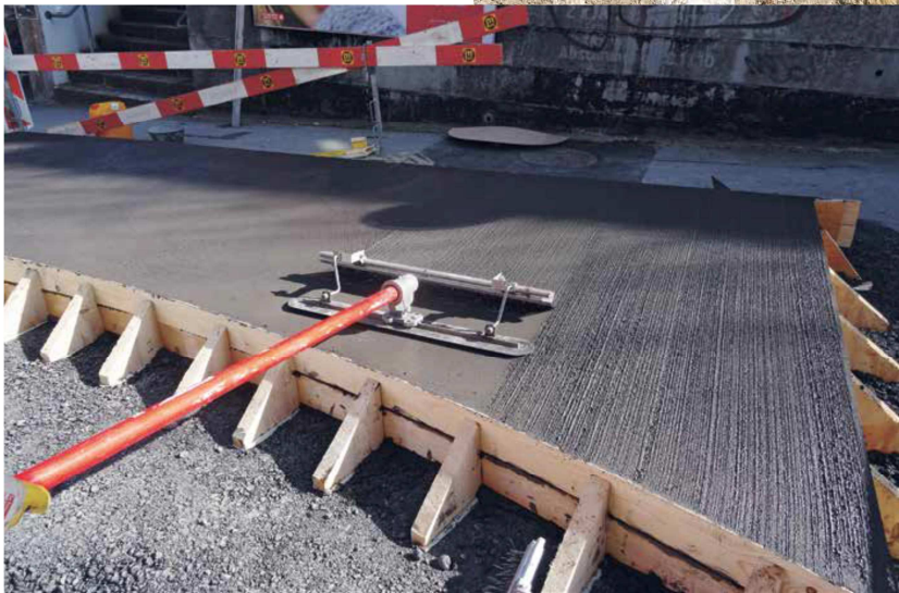
Fig. 23: Exemple de finition au balai
